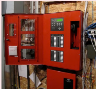
Sistem penggera kebakaran (fire alarm system)
